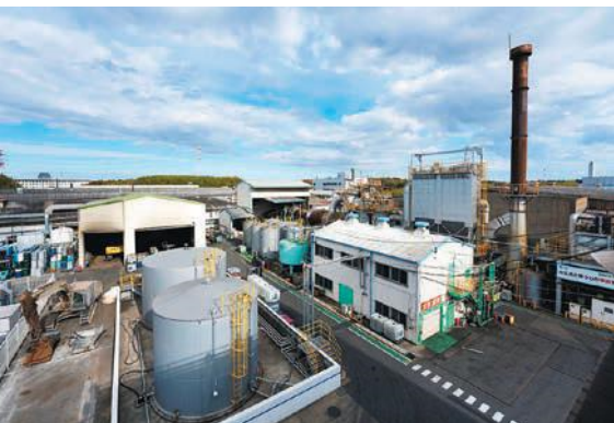
工場内は、BWFやエマルジョン燃料を生成する施設、焼却処理をする設備、研究開発棟など、さまざまなセクションに分かれて運営されている
