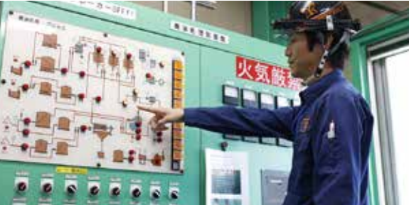
定期的な設備点検
