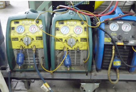
フロン類の回収（第一種フロン類充填回収業者登録）
