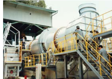
大型焼却炉竣工工事
