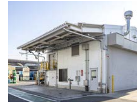
エマルジョンプラント竣工
