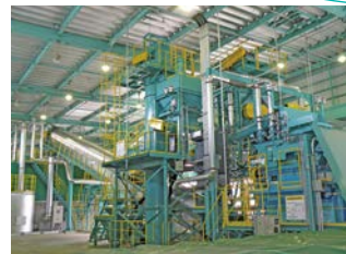
BWFプラント竣工
